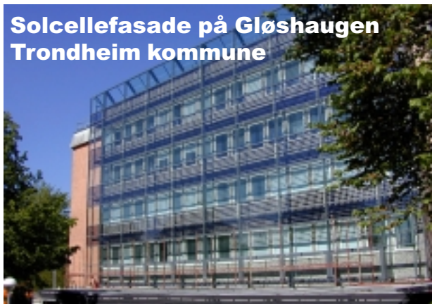
Dobbelfasade med solceller i laminert glass på NTNU
